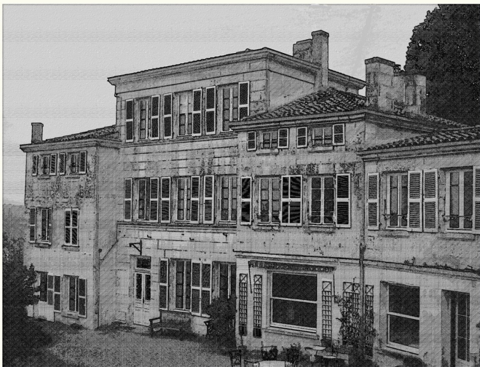
27, rue Perrière à Niort
